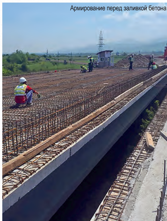
Конструкции транспортных развязок залиты с добавкой «Пенетрон Адмикс»
