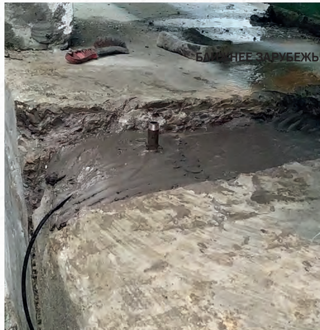
Лечение бетона на 2-м фильтре материалами «Пенекрит» и «Скрепа М 600 Инъекционная»
