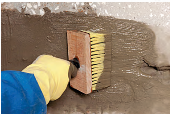
Рис. 12. Обработка штрабы смесью «Пенетрон»
