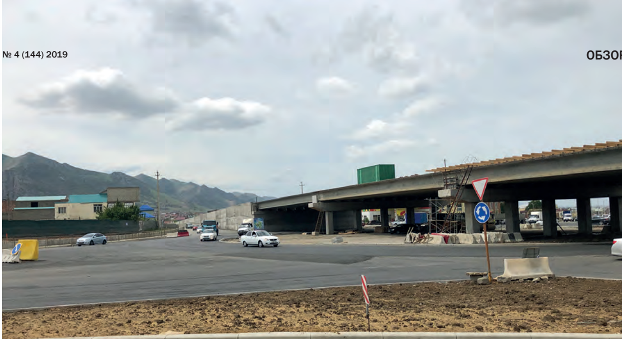
Строительство транспортной развязки в Махачкале
