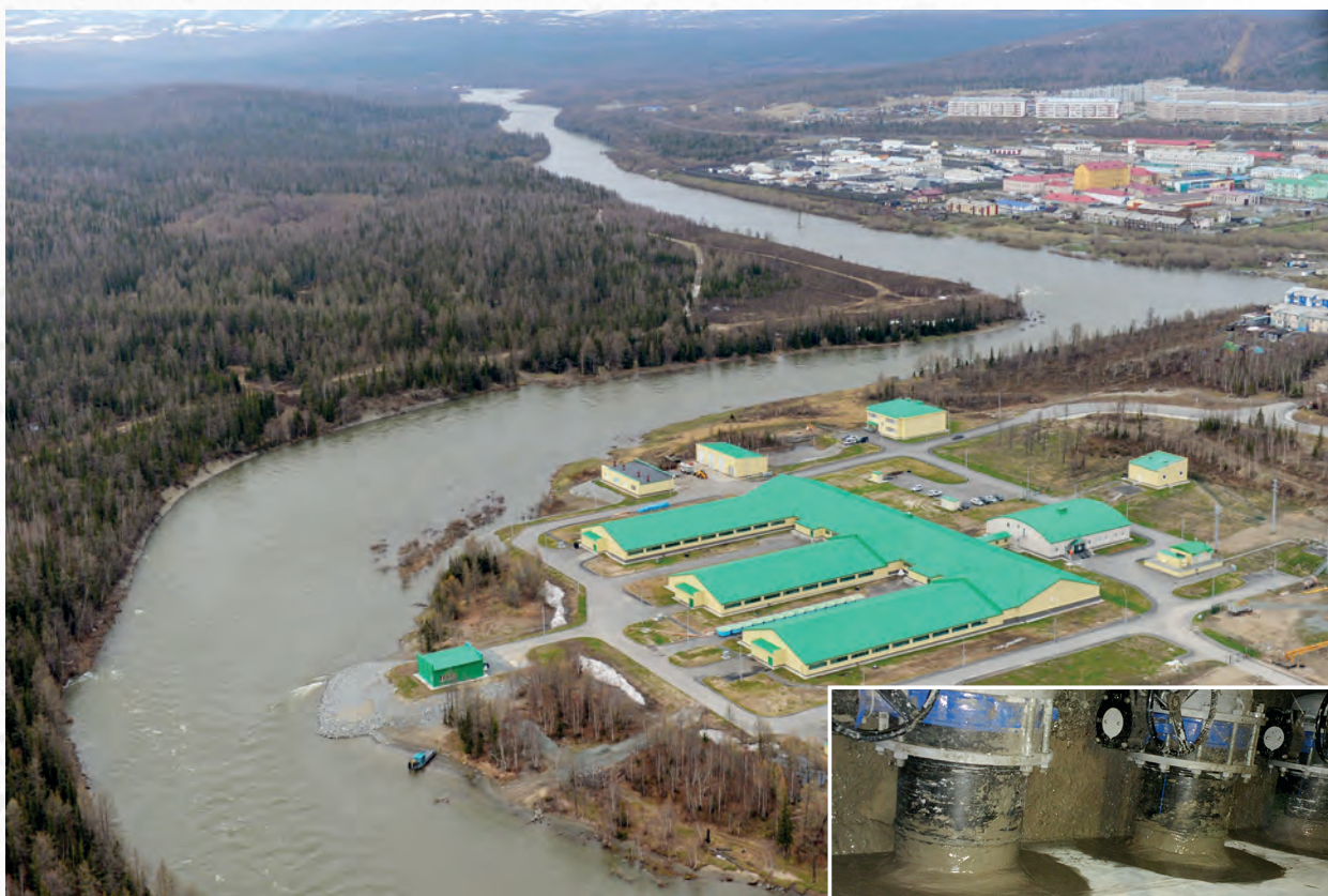
Гидроизоляция бетонных чаш Собского рыбоводного завода
