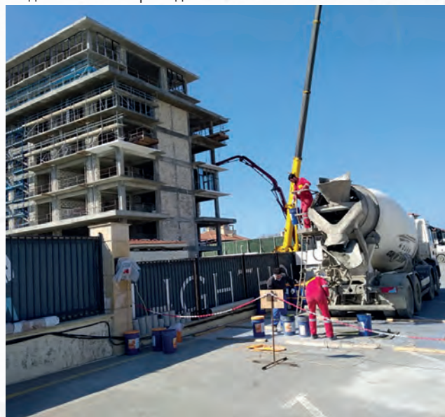
Фундаменты комплекса залиты с добавкой «Пенетрон Адмикс»
