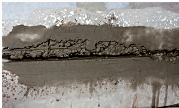
Рис. 9. Штраба, загрунтованная растворной смесью «Пенетрон»
