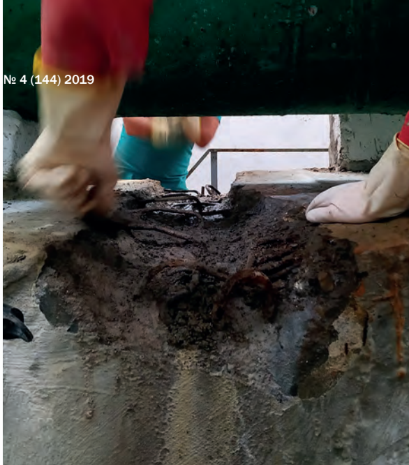
Лечение бетона на 2-м фильтре материалами «Пенекрит» и «Скрепа М 600 Инъекционная»
