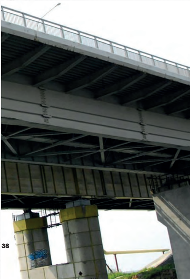
Опорные и пролетные конструкции моста обработаны Пенетроном
