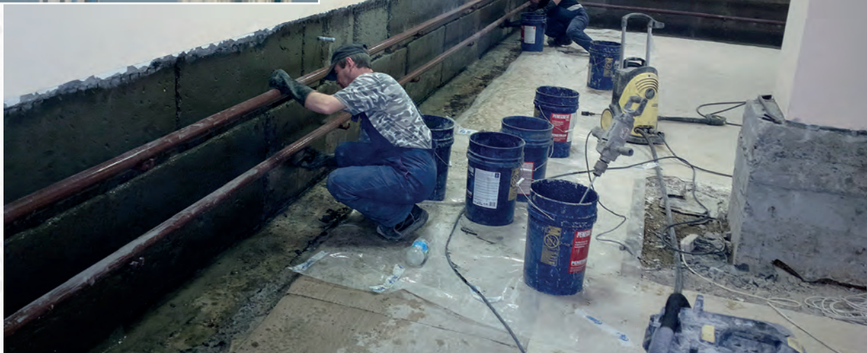
Гидроизоляция офиса компании «Газпром добыча Надым»
