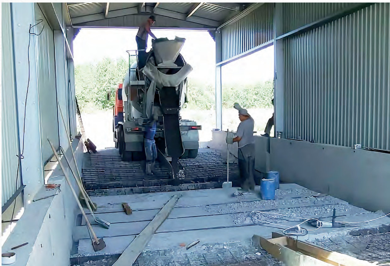
Рис. 5. Бетонирование бетонной плиты дезбарьера
