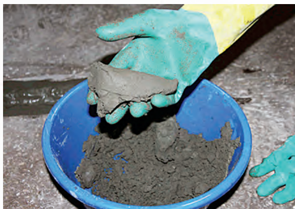
Рис. 10. Приготовление смеси «Пенекрит»
