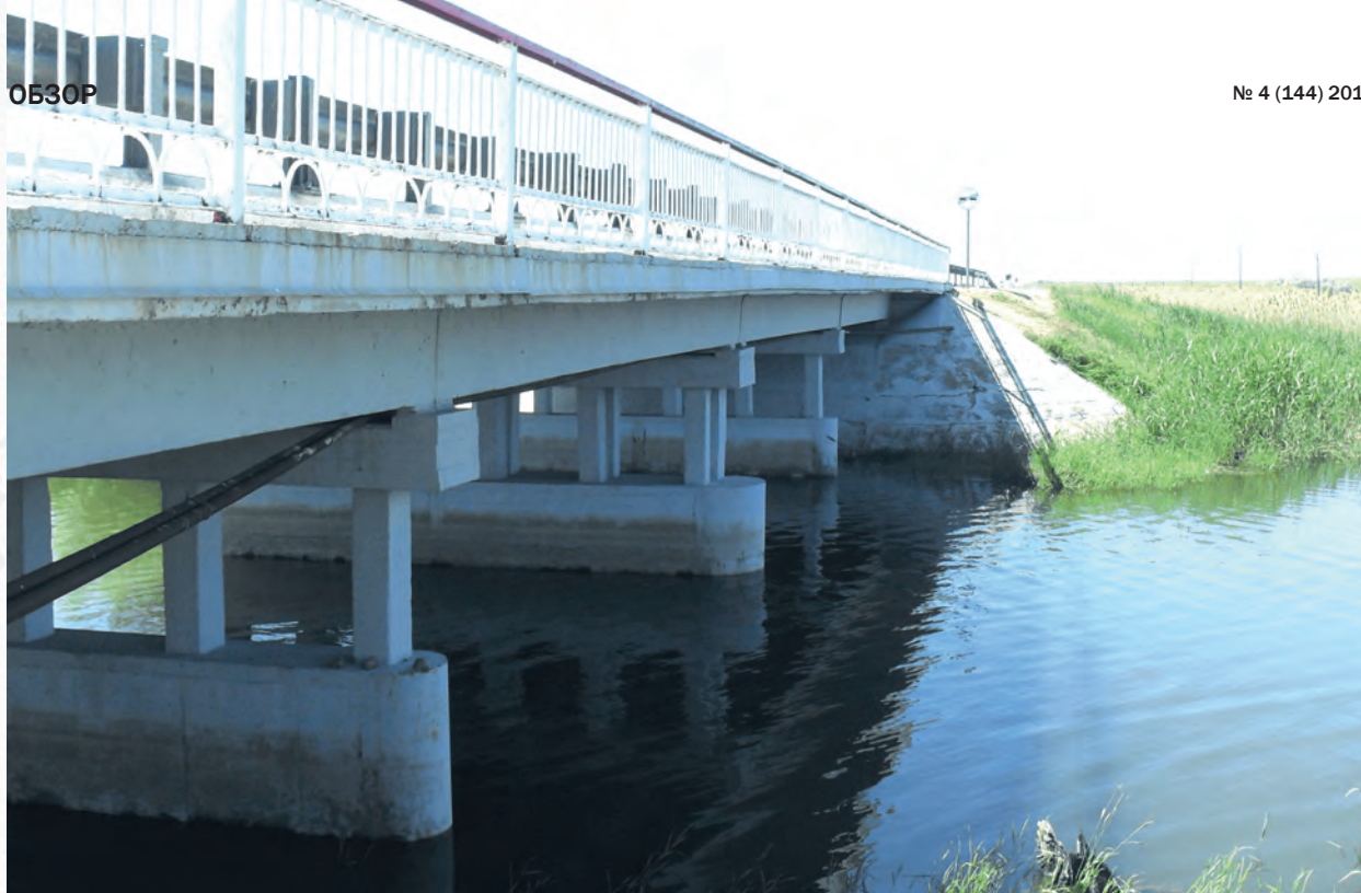
Мост через реку Караульная
