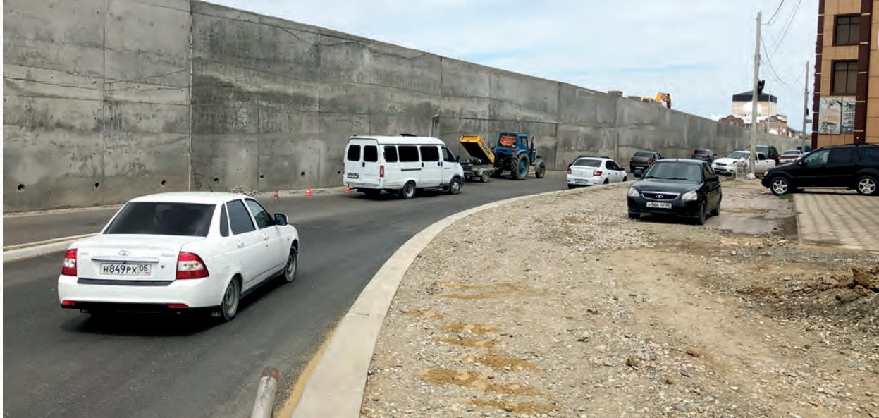
Строительство транспортной развязки в Махачкале
