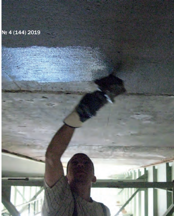
Нанесение материала «Пенетрон»
